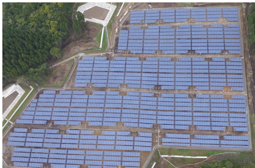
宮之浦太陽光発電所(鹿児島県)/(DC):約2.8MW
