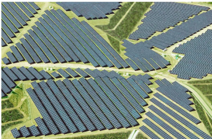
(Kakuda Solar Power Plant)
